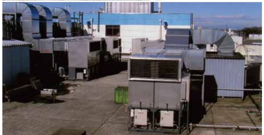
大型脱臭システム(食品工場) 乾式オゾン+水ミスト排気脱臭システムの ユニットを組み合わせる事で、 大風量の排気脱臭対策にも最適な システムをご提案いたします。
