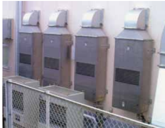
6G30F 4台(給食センター) 一系統の排気を分割し、並列 処理しています。 複数台数を組み合わせる事に より、大風量にも対応します。
