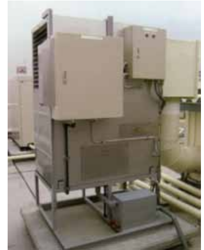
6G40F(スーパー：惣菜バックヤード) 据付ベースを含んだ一体型なので 設置が安易です。
