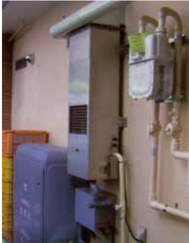
3G20F(カレーチェーン) ビル1階の店舗。ダクトを屋上まで 上げずに店舗部分に設置
